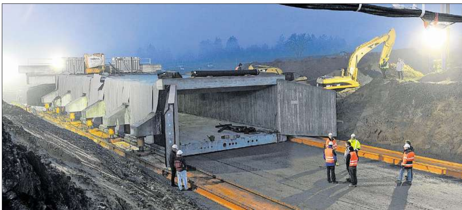
NACHTARBEIT: Das fertige Betonbauwerk wartet auf den Transport. Es geht nur um gut 30 Meter, doch für die ist ein hoher technischer Aufwand erforderlich. Seit heute morgen fahren Straßenbahnen über der neuen Straßenunterführung bei Jöhlingen. Fotos: Alábliso
